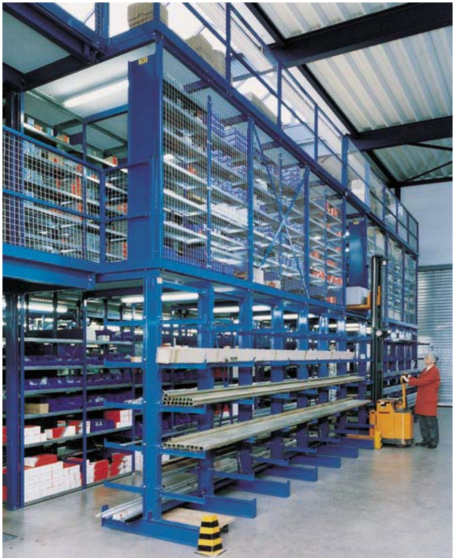
Bild 14-3: Mehrgeschossige Regalanlage mit Absturzsicherung
