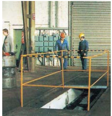
Bild 7-8: Bei Wartungs- und Reparaturarbeiten sind Öffnungen gegen Hineinstürzen von Personen zu sichern
